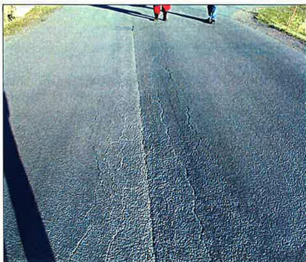
Figur 15-16 Provsträckor vid Gumpekulla. Bärighetsskador i vänster hjulspår, som sammanfaller med beläggningens mittskarv. (Foto: VTI Safwat Said, 1999)
